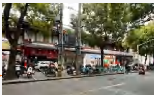
坡顶中式风格类建筑
