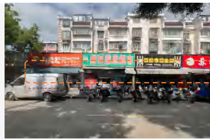
伸缩雨棚破旧凌乱
