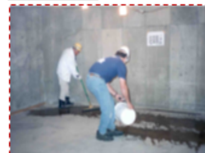
均匀喷洒密封固化剂
