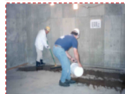
均匀喷洒密封固化剂
