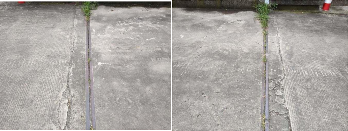
0#台顶伸缩缝堵塞
