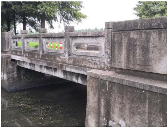
1#左侧栏杆锈胀露筋
