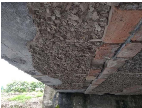
1-1#空心板混凝土附着物
