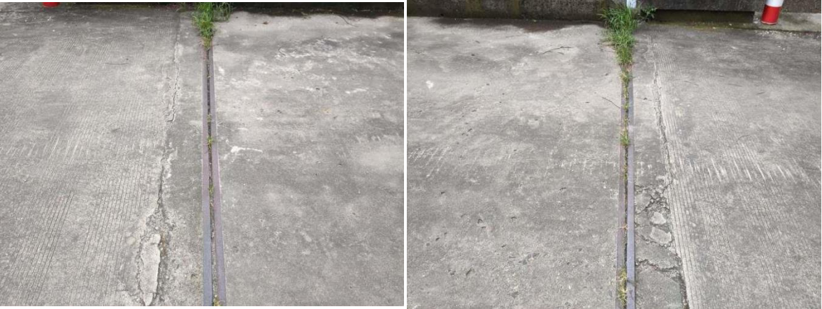
0#台顶伸缩缝堵塞
