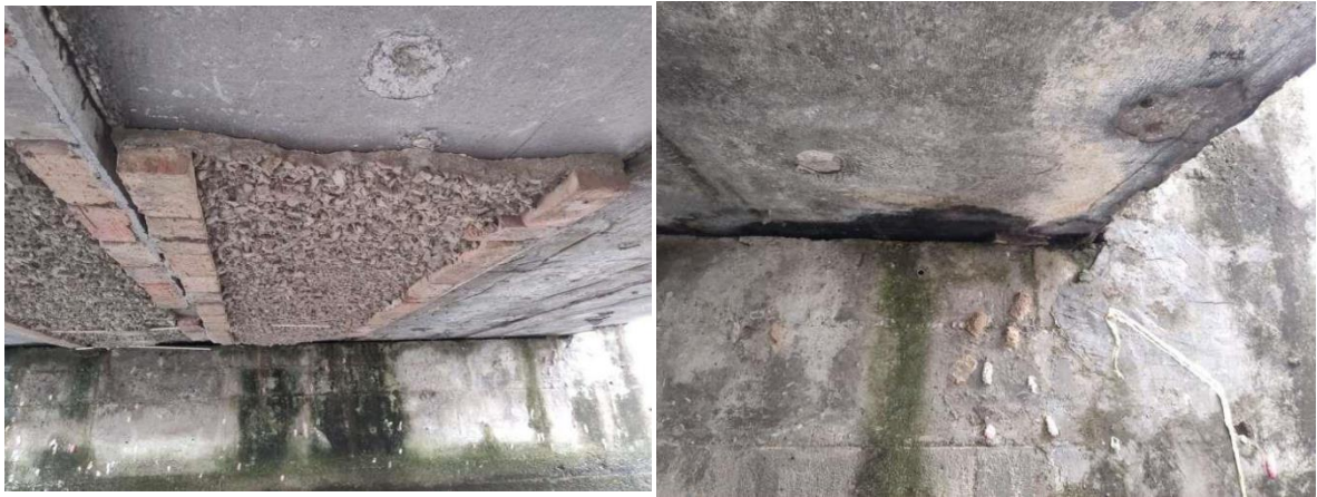
1-3#空心板混凝土附着物
