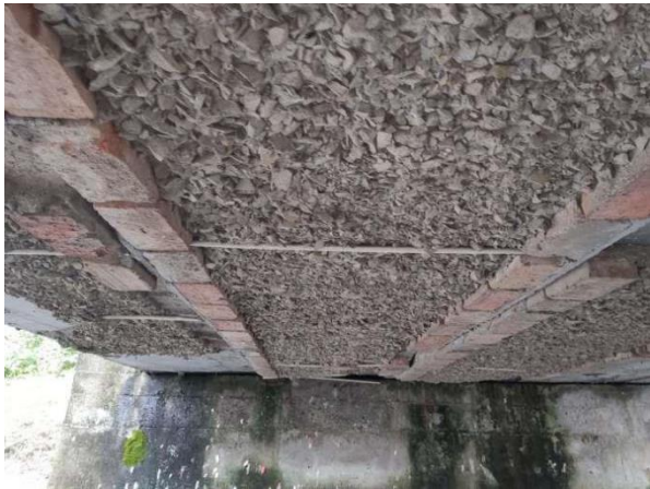
1-2#空心板混凝土附着物
