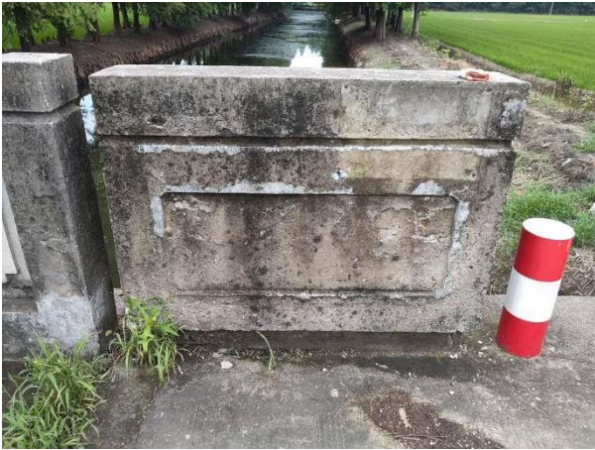
1#桥铭牌破损露筋
