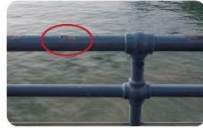
栏杆油漆脱落、锈蚀
