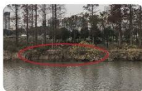
土堤塌陷、裂缝
