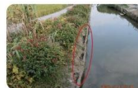
柔性护坡裂缝、塌陷
