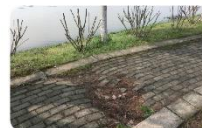
通道路面坑洼、开裂、塌陷、沉降
