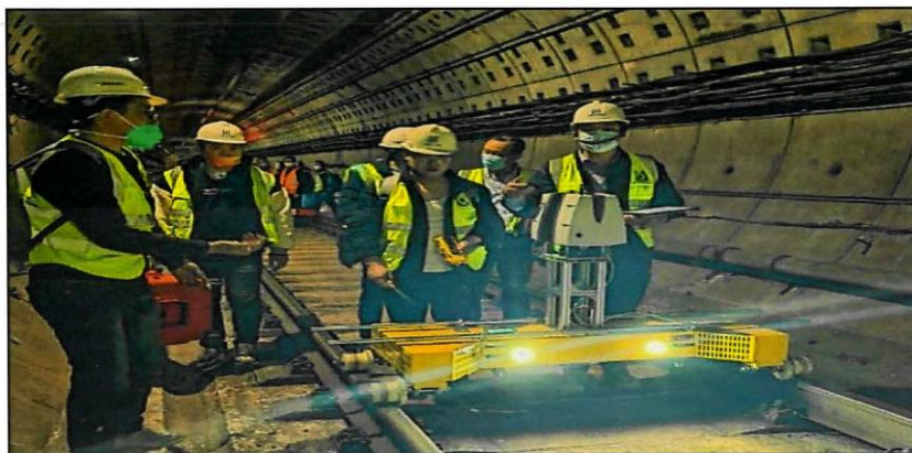
图48 隧道三维激光扫描作业
