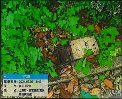
图40 深桩水准点点之记及现场照片 (1) 轨行区基准点布设:
