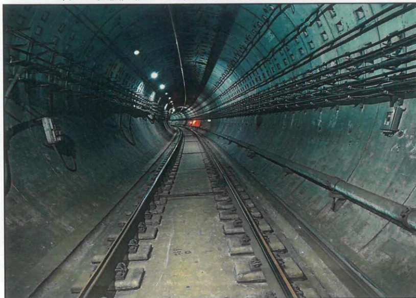
图15 8号线黄兴路站~江浦路站下行线弹性支撑块整体道床现状
