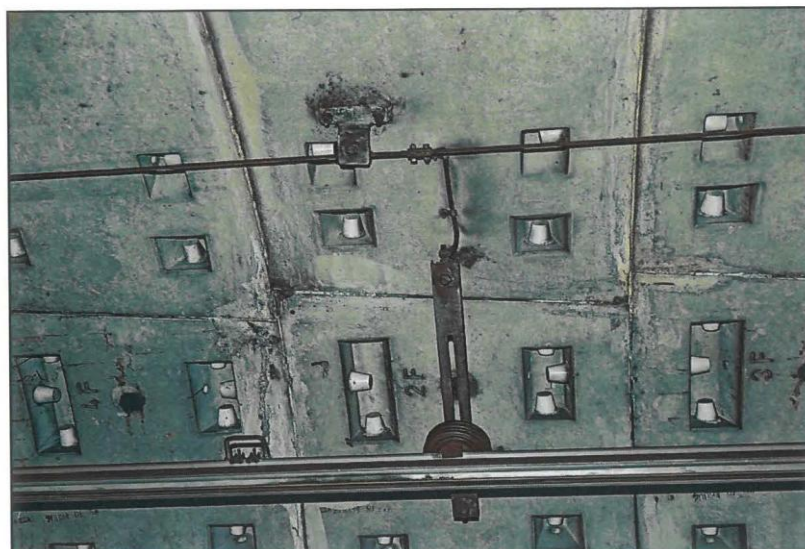
图18 上行线 523 环-525 环上方封顶块与内侧连接块有堵漏痕迹
