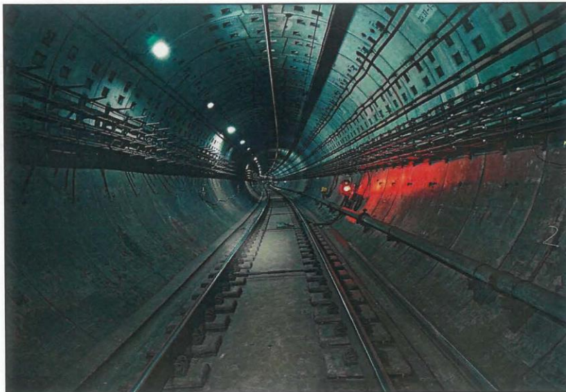
图14 8号线黄兴路站~江浦路站下行线弹性支撑块整体道床现状
