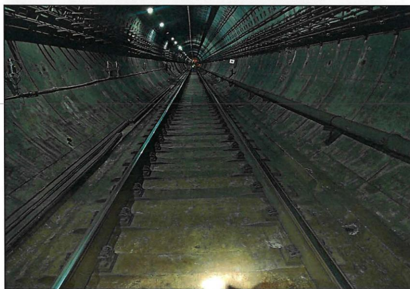
图13 8号线黄兴路站~江浦路站上行线长轨枕整体道床现状
