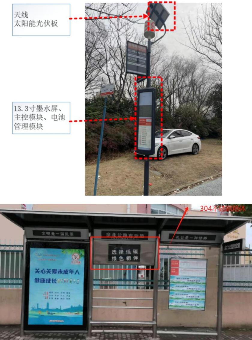
供电采用光伏发电，由光伏板、太阳能充放电控制器、蓄电池、直流负载或交流负载等构成。光伏板在有光照的情况下将太阳能转换为电能，通过太阳能充放电控制器给负载供电，同时给蓄电池组充电；在无光照时，通过太阳能充放电控制器由蓄电池组给直流负载供电。
